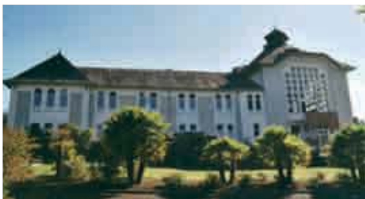
Estación Termal La Roche-Posay. Francia.
